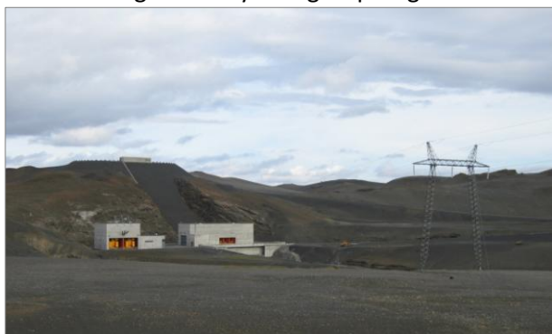
Mynd 4. Vatnsfellsvirkjun og Vatnsfellslína.
